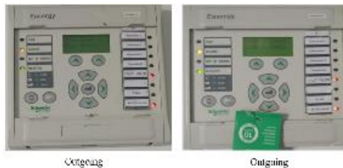
Gambar 4. 7 Indikasi Trip Multifeeder Pada Relay
