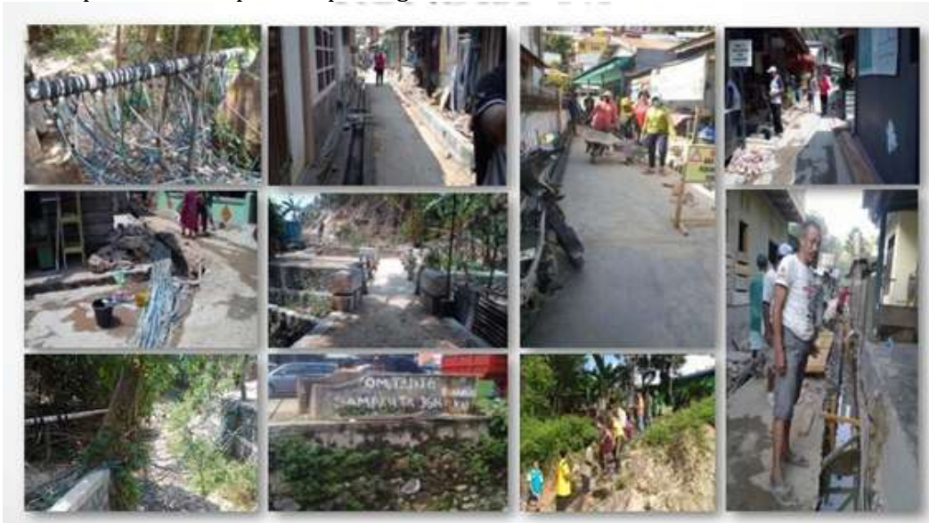
Gambar 9 ; Kondisi Sebelum Penanganan Kawasan
