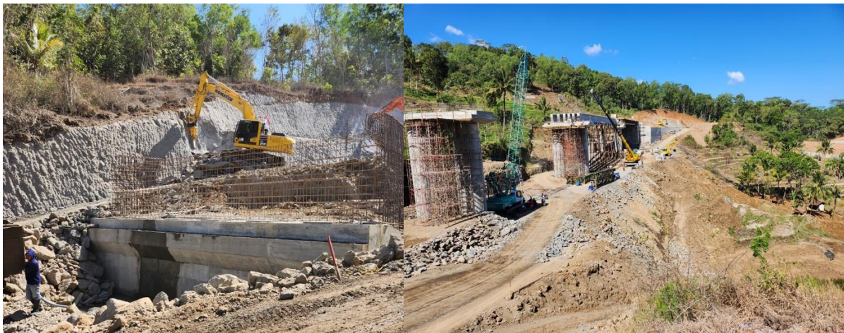
Gambar 2. Kondisi Pembangunan Jalan Alternatif Gunungkidul-Sleman Sumber: Dokumentasi Peneliti
